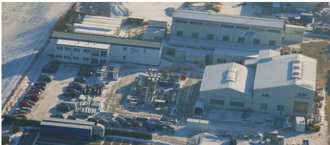
KTI Plersch Kältetechnik GmbH in Balzheim
